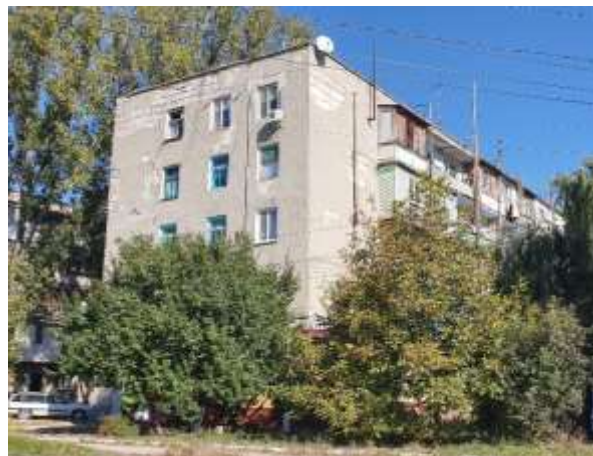
Bloc locativ 5 nivele, str. Șoceaia Bucovina 13
