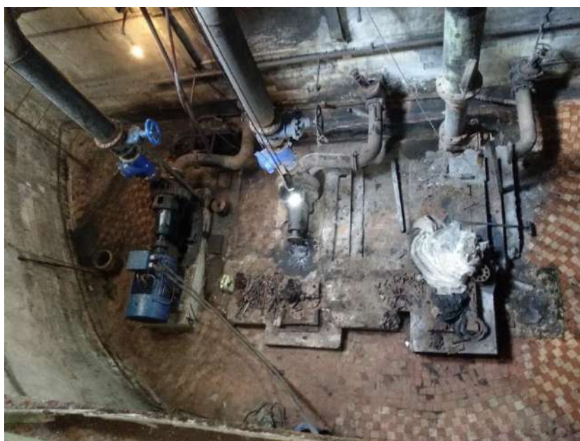
Figura 4-7: Agregatele de pompare SPPAU-1
