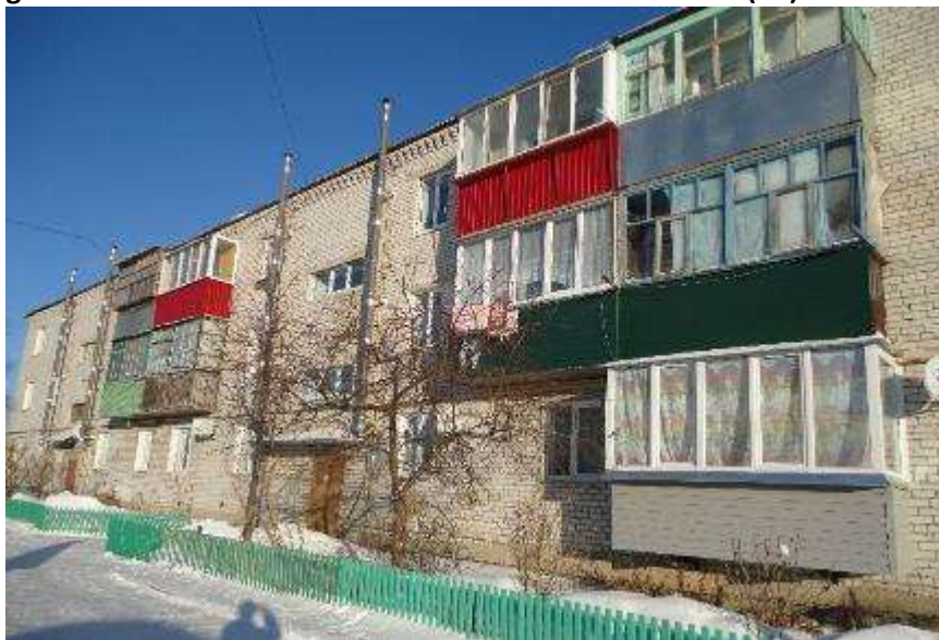
Figura 15: Bloc locativ cu sisteme de încălzire individuale (coșurile de fum)
