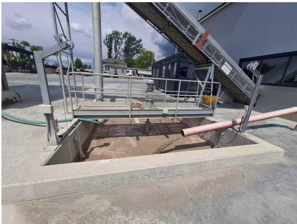
Figura nr. 2. Sistem tehnologic pentru colectarea și recircularea apelor tehnologice existent.
